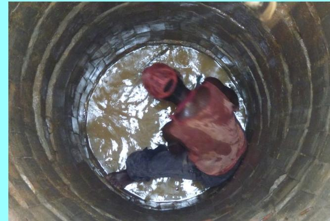
Fabriquer les buses et les descendre au fond du puits
